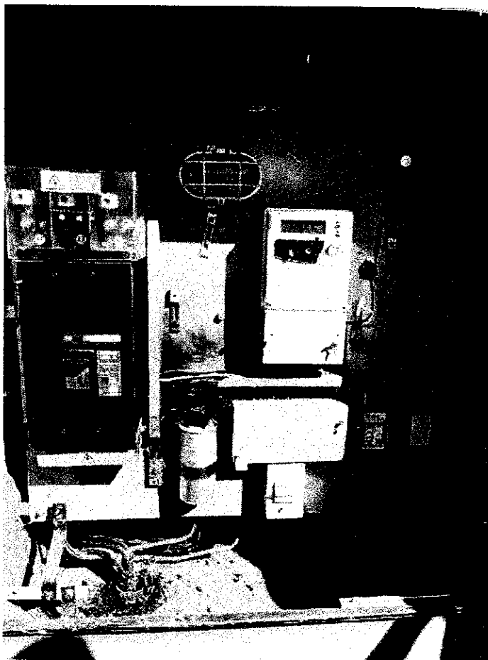
Obrázek 2 - elektroměrový rozvaděč
